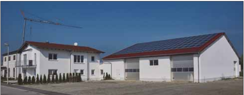
Neuer Bauhof im Gewerbegebiet Niedererlbach: Den aktuellen Stand der Umbauarbeiten besichtigten Bürgermeister und Gemeinderäte am 1. August 2016. Weitere, für einen Bauhof notwendige Ausbaumaßnahmen wurden in der anschließenden Gemeinderatssitzung festgelegt.
